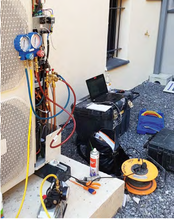
▲ Bild 6 • Der Kältekreislauf wurde sorgfältig auf Dichtheit getestet.
