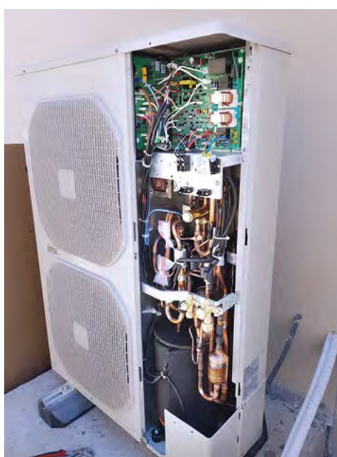
▲ Bild 3 • Geöffnete Außeneinheit der Zwei-Kanal-VRF-Anlage der ECOi-Baureihe.
