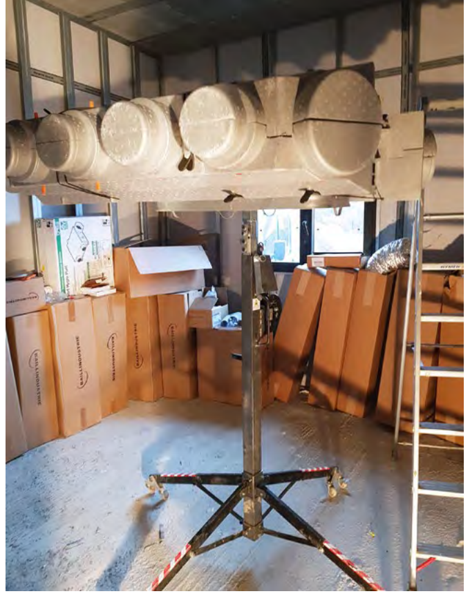
▲ Bild 7 • Montagehilfe für die Erdgeschossereinheit.
